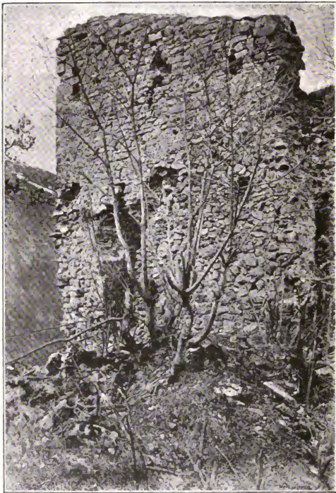
Fig. 11. Südliche Burgmauer von Bobovac.
